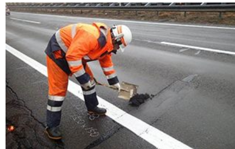
常温合材による簡易補修
