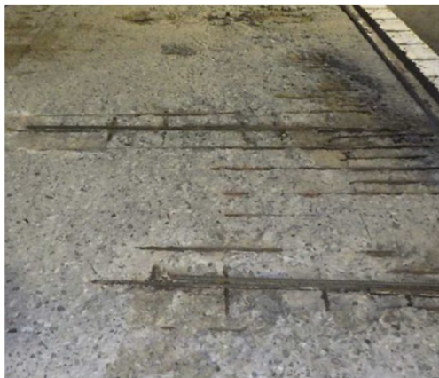
床版上面の土砂化有
