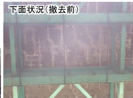
床版上面の 浮き・砂利化、土砂化
