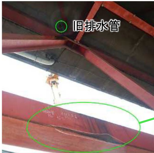
【旧排水管からの漏水による変状】
