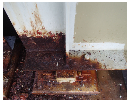
主桁端部の腐食（健全度Ⅰ）
