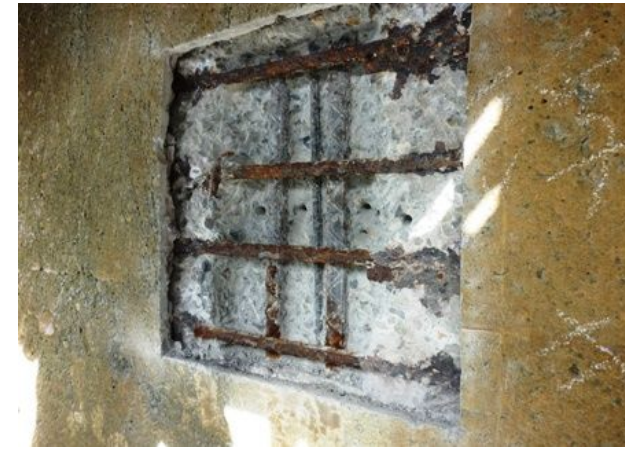
漏水部の鉄筋（断面欠損を伴う腐食）
