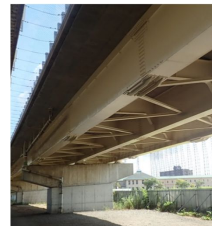
鋼桁の劣化した塗装の塗替え
