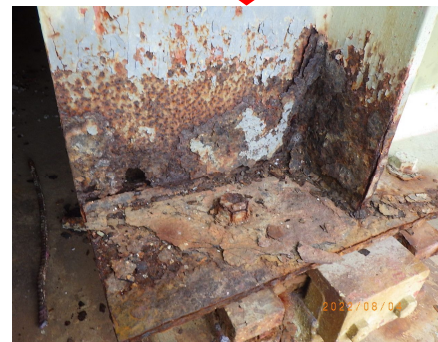
主桁端部の腐食（健全度Ⅲ-2）
