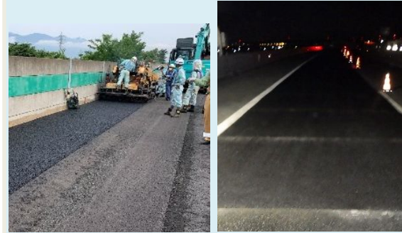
路肩部を走行帯に改良 対面通行車線の事前補修 事前の舗装補修
