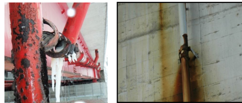
凍害による破損
