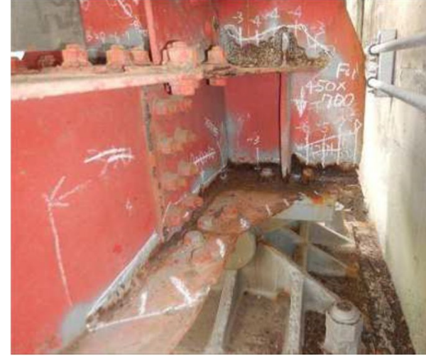
【部材端部の塗膜割れ】
