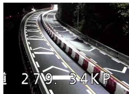
分離帯防護柵設置及び導流レーンマークの設置
