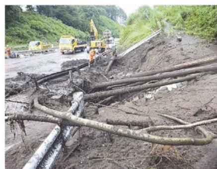
被災状況(C-BOX閉塞)
