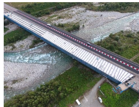
高炉スラグ微粉末を採用したプレキャストPC床版 (北陸道 早月川橋)
