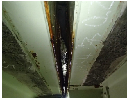
伸縮装置の漏水（二重止水無し）
