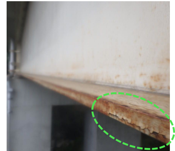
【部材端部の塗膜割れ】
