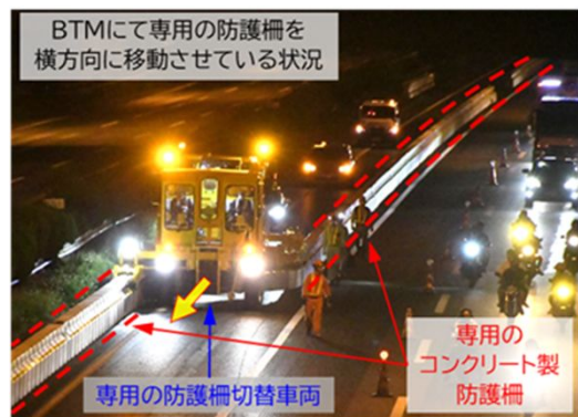
防護柵切替車両を用いた速やかな防護柵設置事例
