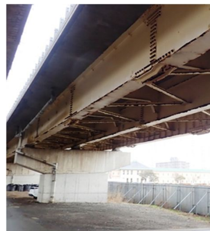
鋼桁の劣化した塗装の塗替え
