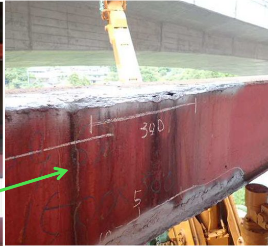
【手摺取付け部材接触部の変状】
