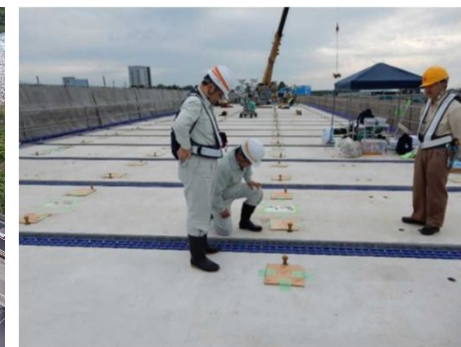
高炉スラグ微粉末を採用したプレキャストPC床版 (北陸道 早月川橋)
