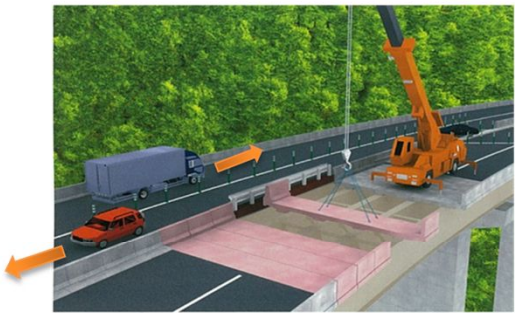
床版取替え工事のイメージ
