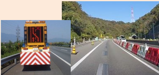
仮設防護柵等による工事規制
