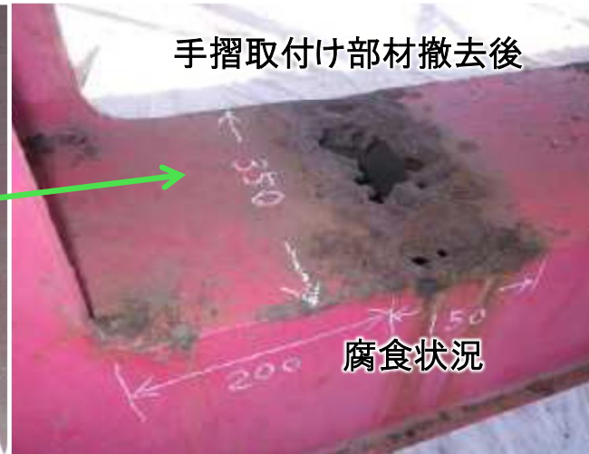
【手摺取付け部材接触部の変状】
