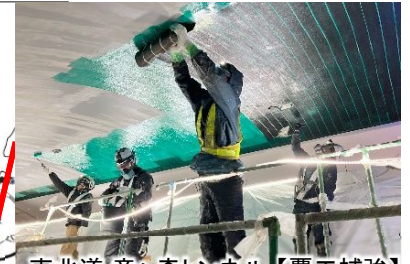
東北道 竜ヶ森トンネル【覆工補強】
