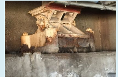
現地照査・設計等を踏まえた支承の補修・補強 (床版取替用足場の有効活用)
