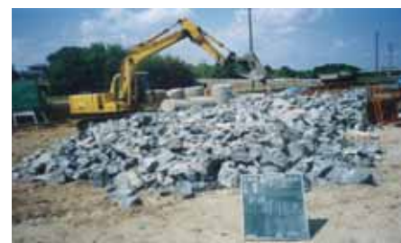
コンクリート塊の再資源化状況 (場所打ち杭の小割り)
