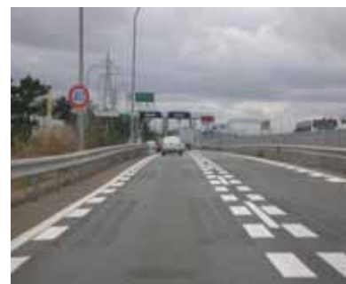
音と振動で注意を喚起する舗装など (試行中)
