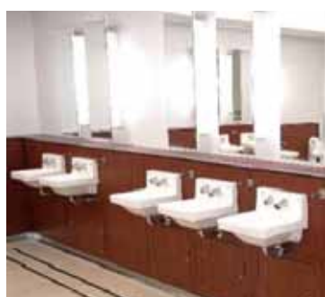
温水対応自動水栓の設置
