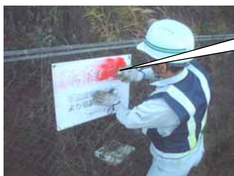
スプレー吹き付け作業の状況
