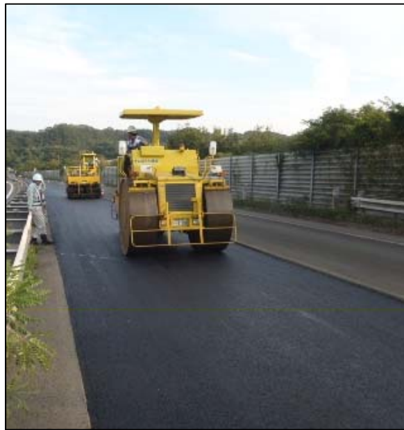
【山形道】仙台管内 舗装復旧状況
