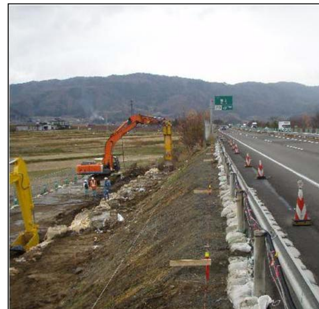
【東北道】福島管内 のり面復旧状況
