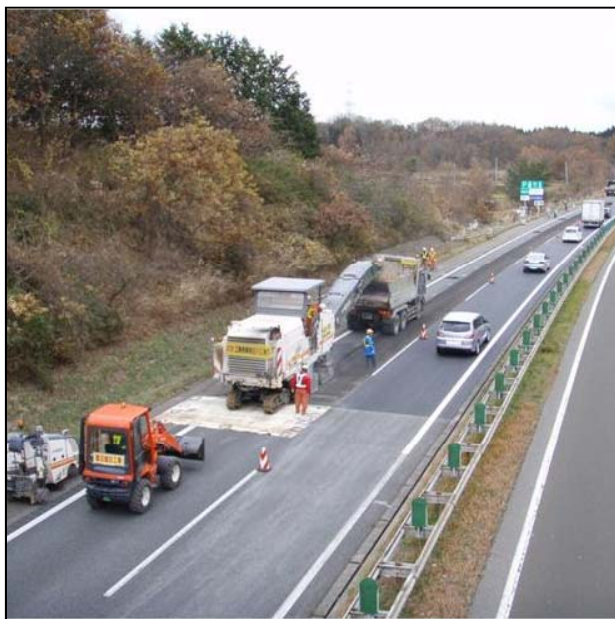
【東北道】古川管内 舗装復旧状況
