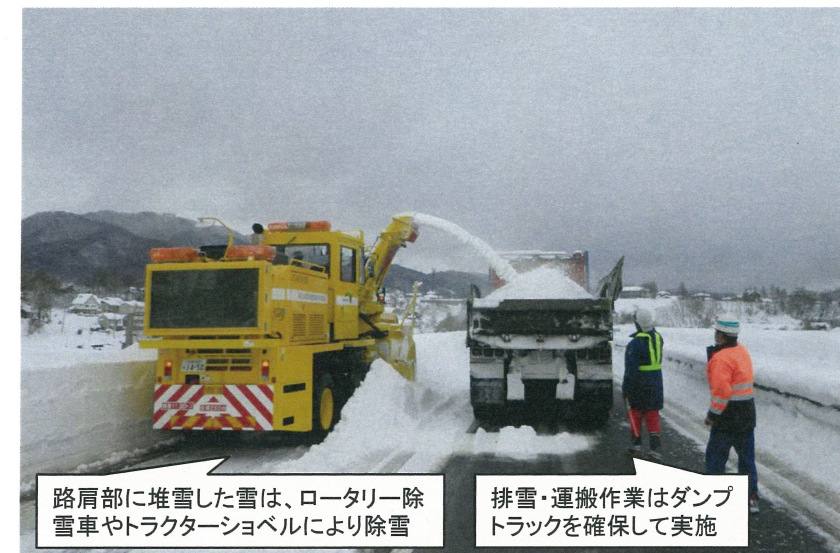
ロータリー除雪車による除雪及びダンプトラックによる排雪・運搬状況 （撮影箇所③：上信越道 佐久平PA～佐久IC）
