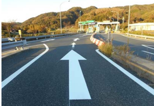
大型矢印路面標示(ランプ合流部)
