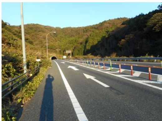
大型矢印路面標示、ラバーポール延伸(高速道路本線合流部)
