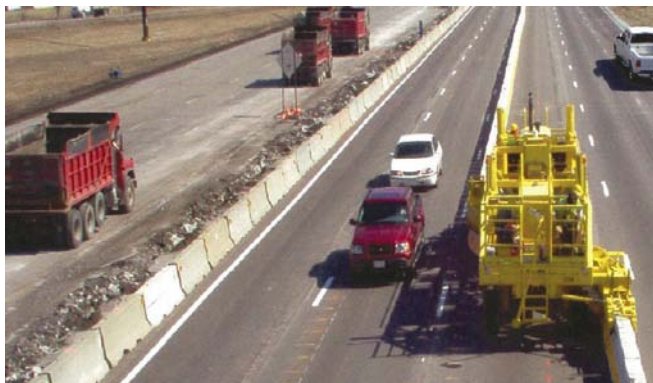
海外での活用事例《防護柵の切替状況》
