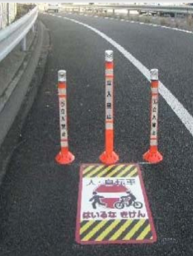
▲逆走対策の実施事例 (IC平面交差部におけるカラー舗装) ▲人等の立入対策の実施事例 (IC出入口部における歩行者進入禁止ポール、立入禁止看板) ▲動物侵入対策の実施事例 (立入防止柵のかさ上げ)
