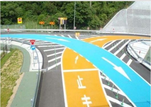
▲逆走対策の実施事例 (IC平面交差部におけるカラー舗装) ▲人等の立入対策の実施事例 (IC出入口部における歩行者進入禁止ポール、立入禁止看板) ▲動物侵入対策の実施事例 (立入防止柵のかさ上げ)
