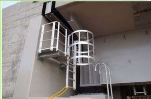
△防食強化としてアルミ製品を用いた事例
