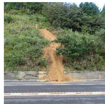
⑥ のり面崩落の状況 (E6 常磐道 常磐富岡 IC～浪江 IC)
