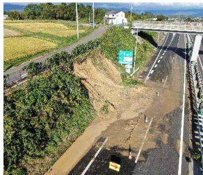
⑤ のり面崩落の状況 (E4 東北道 須賀川 IC～郡山南 IC)
