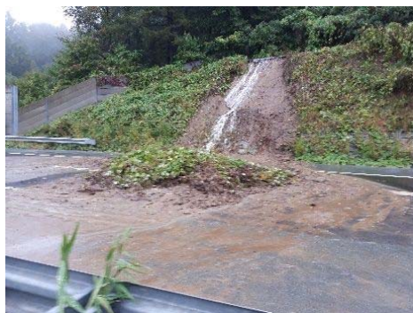
④ のり面崩落の状況 (E18 上信越道 佐久 IC～小諸 IC)
