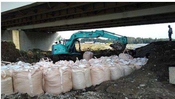
河川決壊箇所の応急復旧支援（壬生町内）
