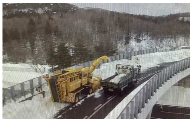
写真 12 橋梁部の雪堤処理状況 (上信越道 上越 JCT)
