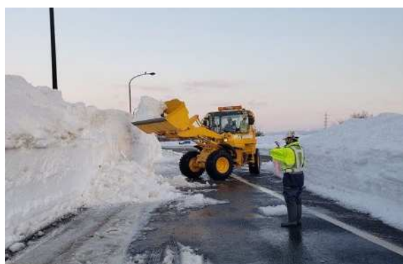
写真 11 雪堤崩し状況 (上信越道 上越 JCT)
