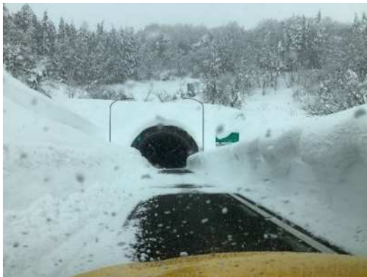
写真2 雪堤の状況（北陸道 能生 IC～名立谷浜 IC）
