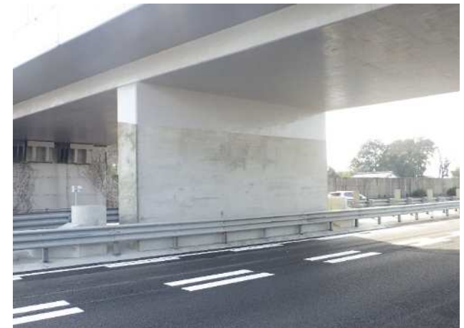
▼ロッキング橋脚(耐震補強後)
