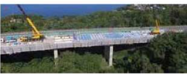
床版取替工事の実例
