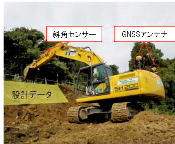
マシンガイダンスバックホウを活用した施工状況
