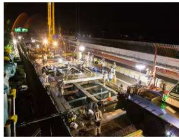
新設コンクリート床版の設置
