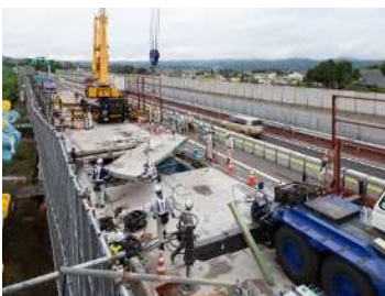
既設コンクリート床版の撤去
