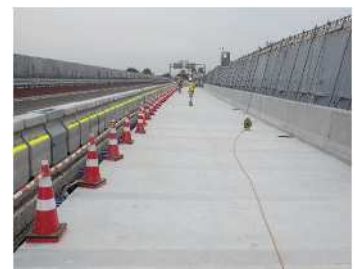
新設コンクリート床版の施工完了
