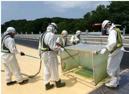
高性能床版防水工
