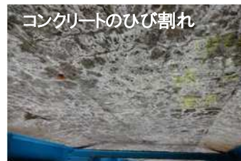
床版損傷状況
