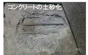
床版損傷状況
