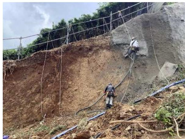
②崩落崖上部の住宅地の安全を確保し、土塊を除去するため土留めを実施
