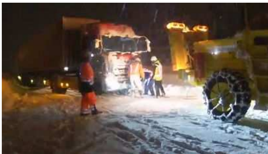
写真 スタック車両の排除状況
