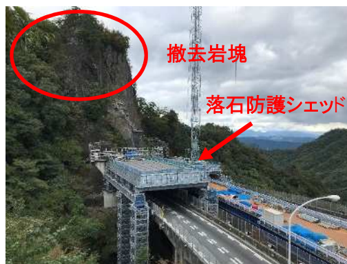
硬岩質地山撤去
