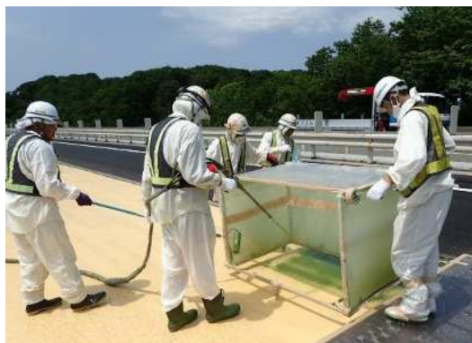
高性能床版防水工
