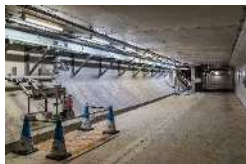
アクアトンネル避難通路
