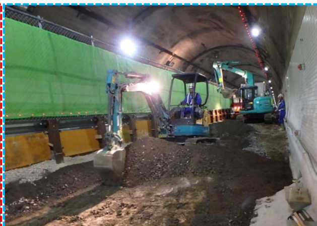
＜半断面の施工状況＞
