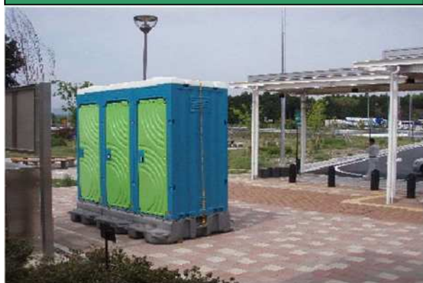
臨時トイレの設置
