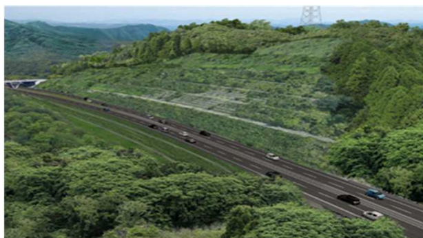
【切土区間のボックスカルバート化+押え盛土】上信越道 蓬平地区
