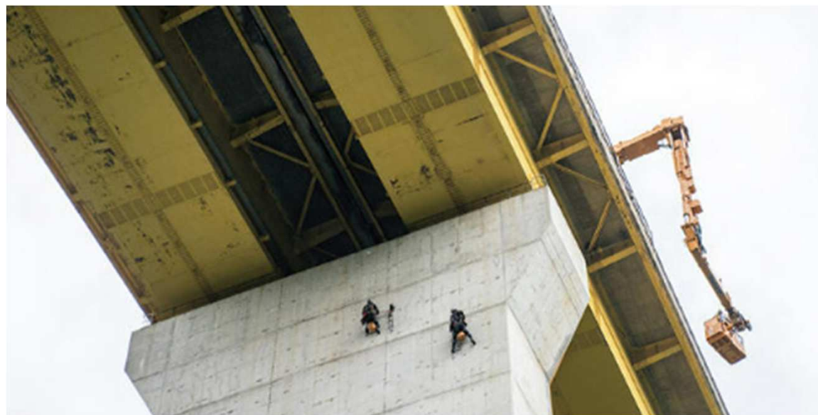
ロープアクセス点検 実施状況
