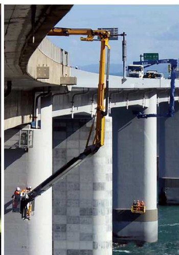
点検用車両による点検
