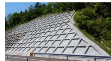
のり面・排水機能の強化対策例
