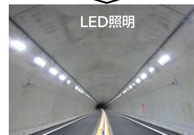
トンネル照明のLED化
