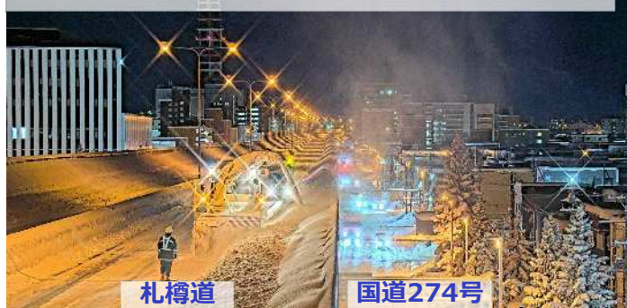
排雪状況【ロータリ除雪】（札幌道 高架橋区間）
