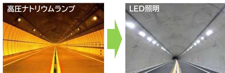
道路(トンネル・明かり部)照明のLED化
