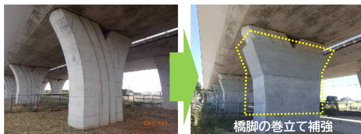
耐震補強の施工
