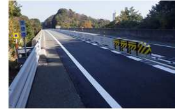
センターブロック
