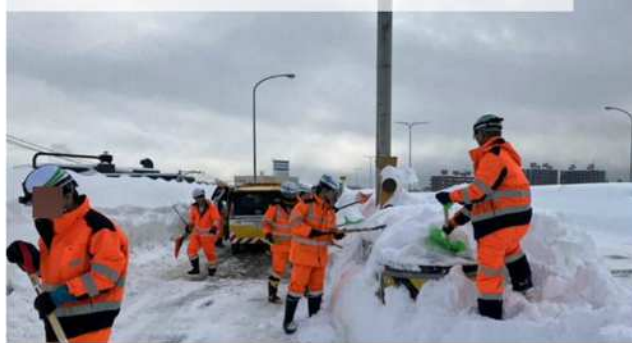
人力除雪状況（道央道 高架橋区間）
