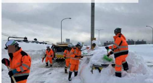
人力除雪状況（道央道 高架橋区間）
