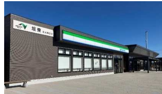
プレハブ工法により新設した坂東PA(外)
