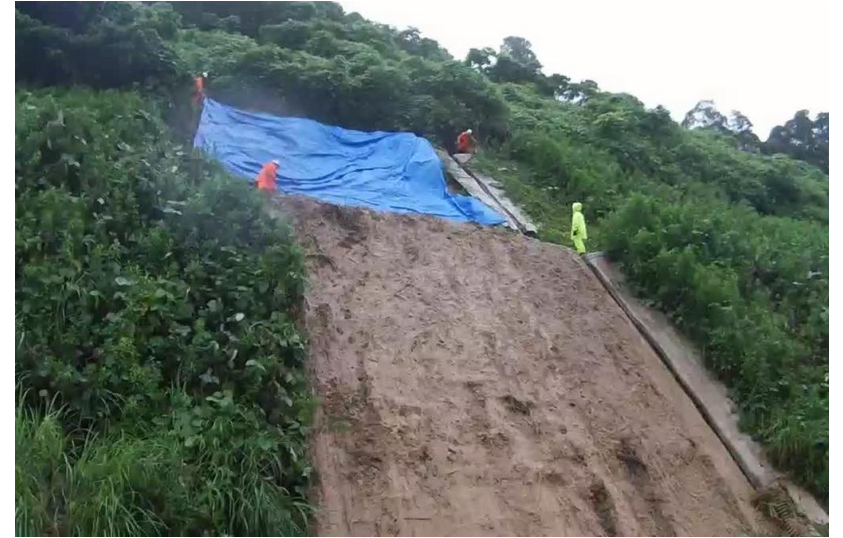
ブルーシート設置（2段階目）
