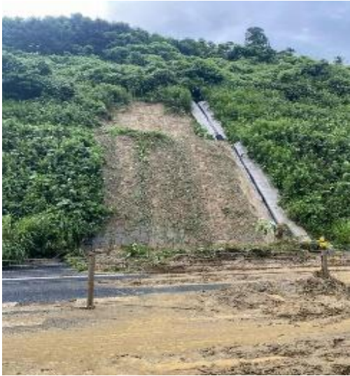
土砂流出状況
