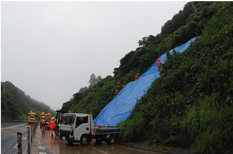
ブルーシート設置（1段階目）
