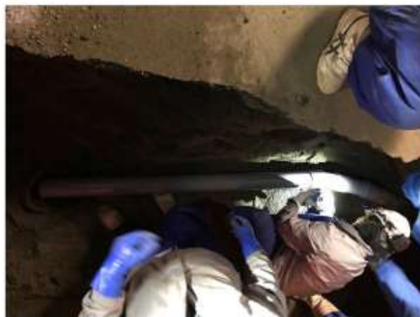
写真4 住宅下水管復旧状況
