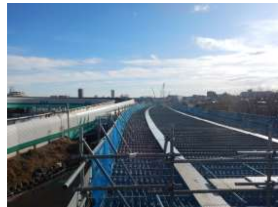
橋梁上部工施工状況(大泉JCT)
