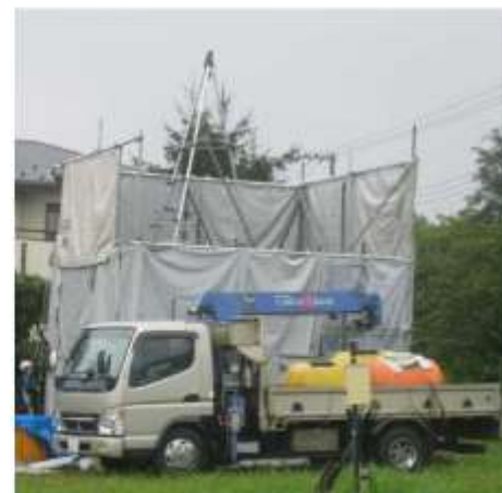
ボーリング調査イメージ
