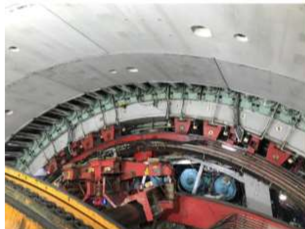
写真1 坑内状況写真(マシン上部)
