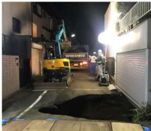
写真1 陥没箇所の応急復旧対応状況(埋戻し)
