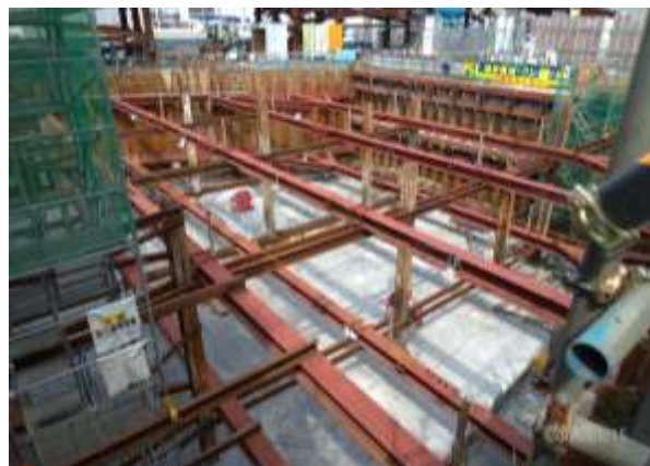
ランプ部開削ボックス施工状況(東名JCT)
