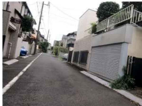
写真1 陥没箇所の事前状況写真 (2020年7月30日)
