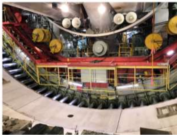
写真2 坑内状況写真(マシン下部)
