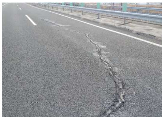
舗装のひび割れ
