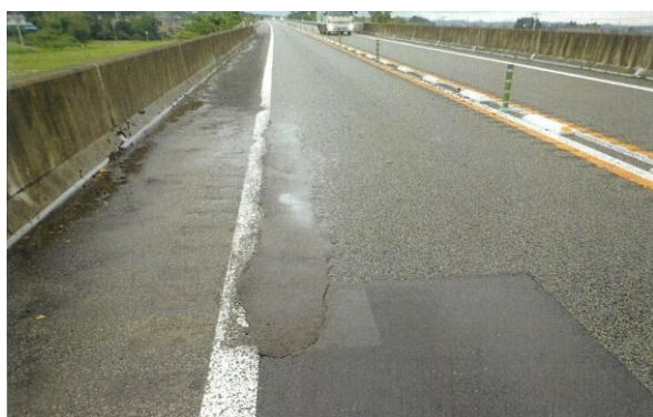
【損傷全景(応急復旧状況)】
