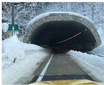
路肩(トンネル部)
