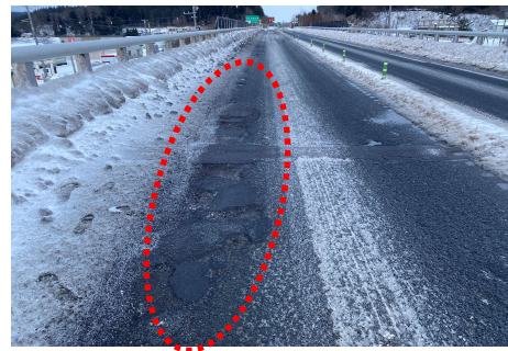
路面損傷状況(ポットホール)
