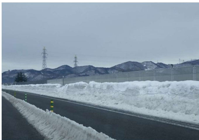
路肩堆雪状況
