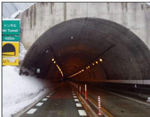
TN坑口部堆雪状況
