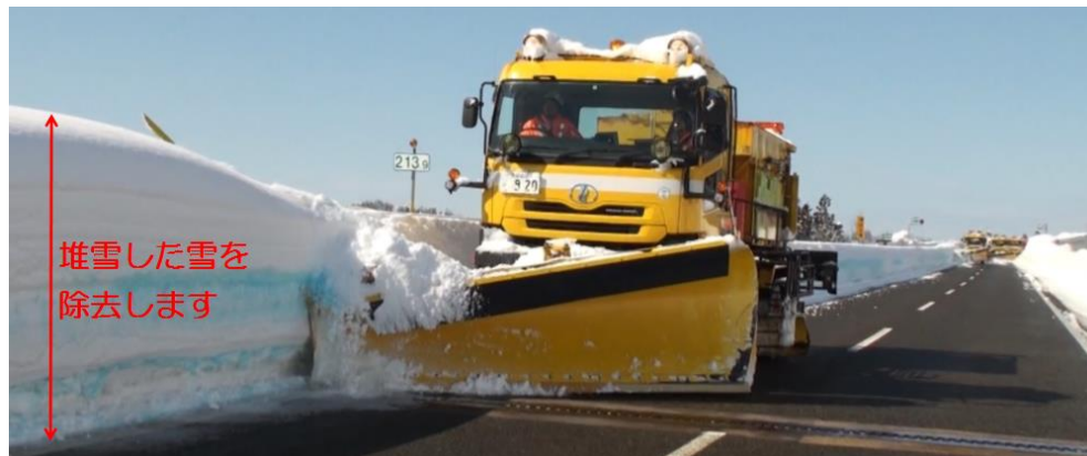
(雪堤の除去作業イメージ)
