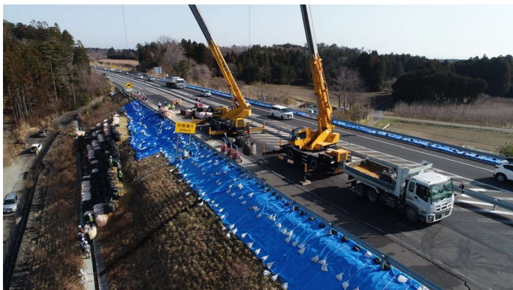
現地作業状況
