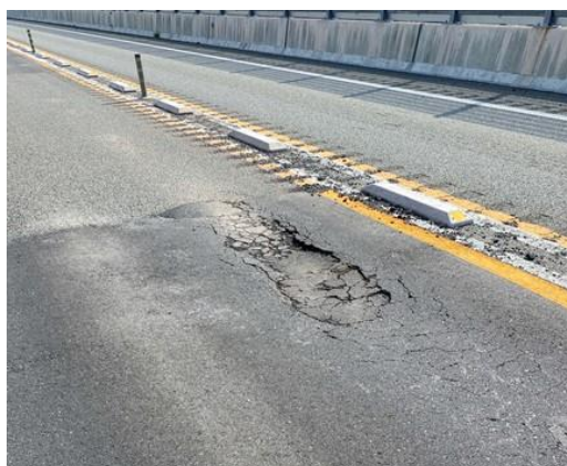
舗装の損傷
