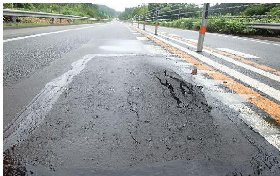
路面損傷状況
