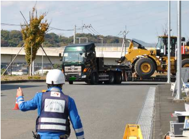
①【中日本高速道路(株)】相模原愛川料金所
