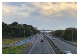
合流部の渋滞緩和のため横浜町田ICの加速車線を延伸しました。さらに、2車線ランプを分離型としスムーズな加速が可能とするためカラー舗装を実施しました。
