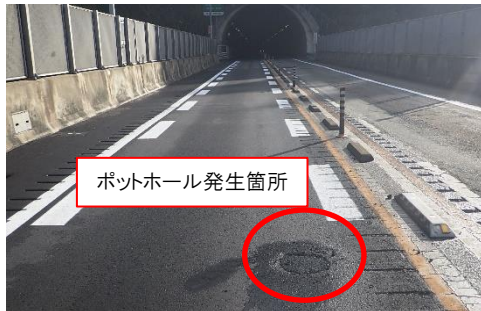
損傷した舗装路面の状況
