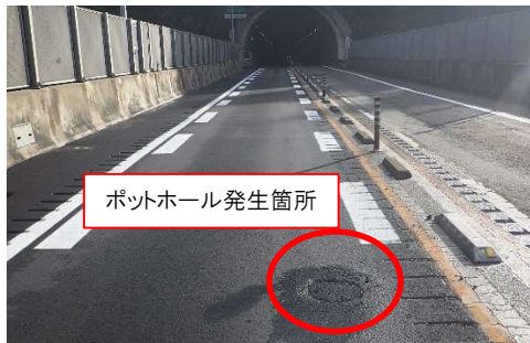
損傷した舗装路面の状況
