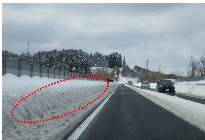
本線路肩部堆雪状況
