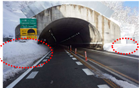
本線路肩部堆雪状況
