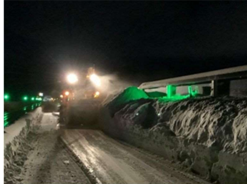
北海道支社管内 後志道の積雪と除雪状況 (令和5年1月10日)
