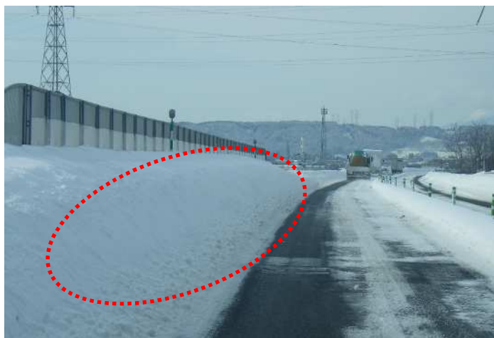
本線路肩部堆雪状況
