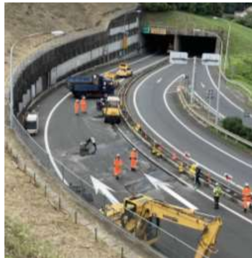
逗子IC 出口 舗装補修状況
