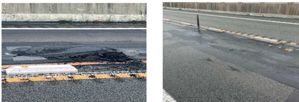
舗装の損傷
