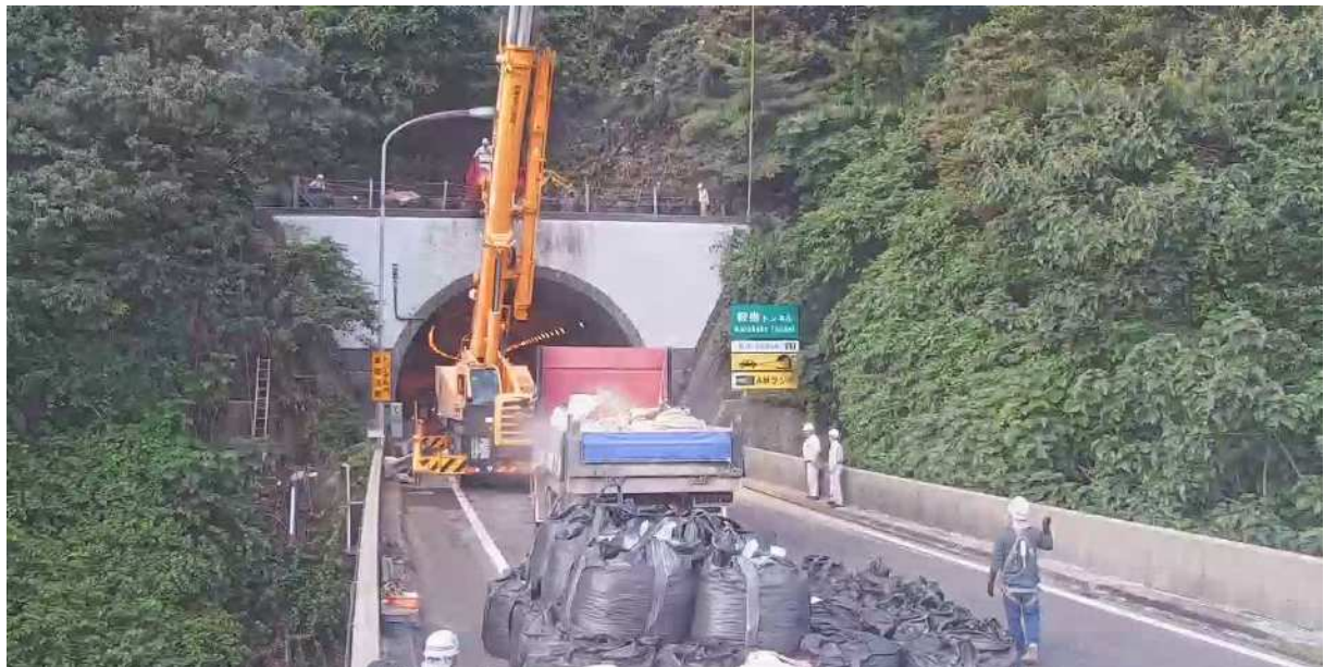
鞍掛トンネル(南坑口)
