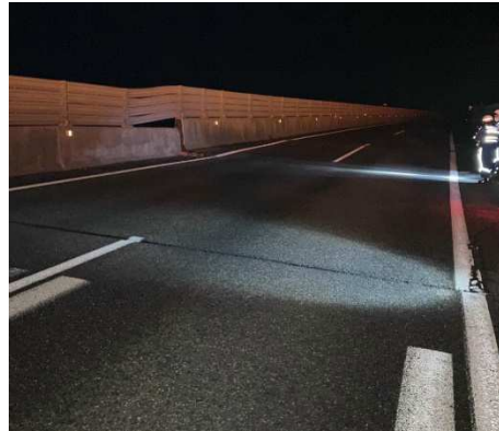
北陸自動車道 能生IC～糸魚川IC 古川橋 (令和6年1月1日)
