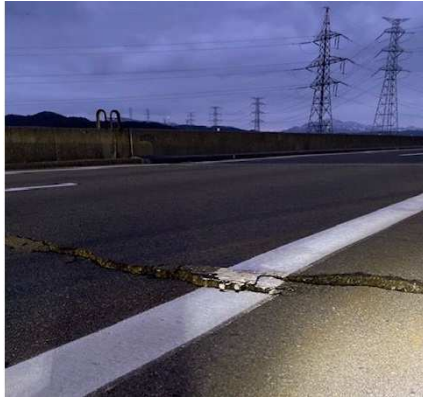
北陸自動車道 西山IC～柏崎IC 吉井川橋 (令和6年1月1日)
