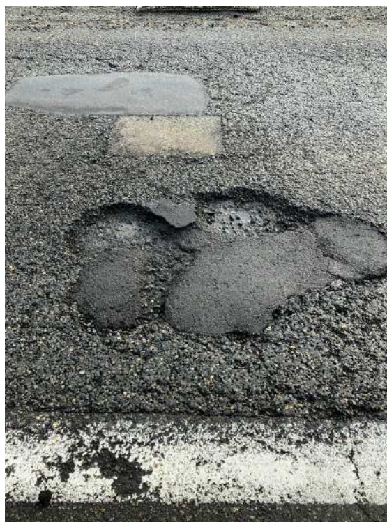
－路面損傷状況－
