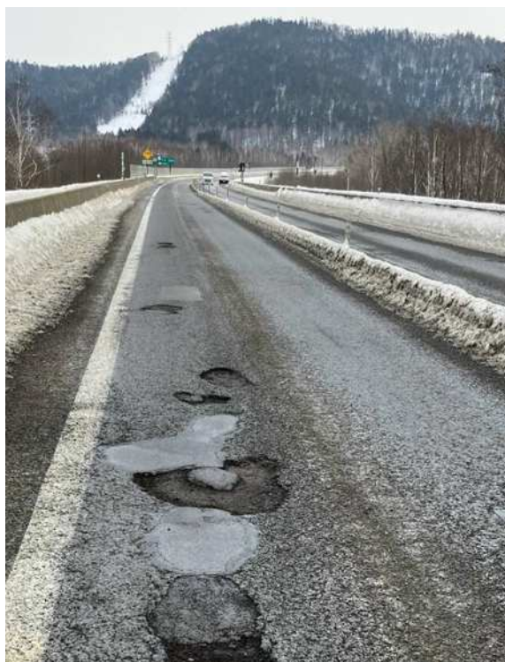
－路面損傷状況－
