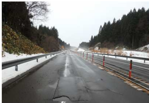
舗装損傷写真
